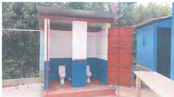
Foto1: Sustrucción de sanitarios y accesorios.
