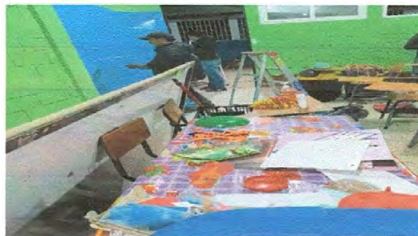
Foto 4: pintura en muros exteriores e interiores.
