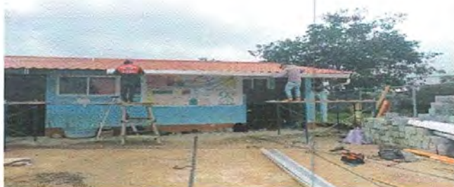
Foto 5: Sustitución de canales de PVC por metal
